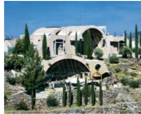
Öko-Siedlung Arcosanti: Vorbilder in den Steilklippen der Canyons
